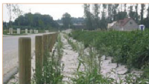
Une noue collectrice des eaux pluviales.
