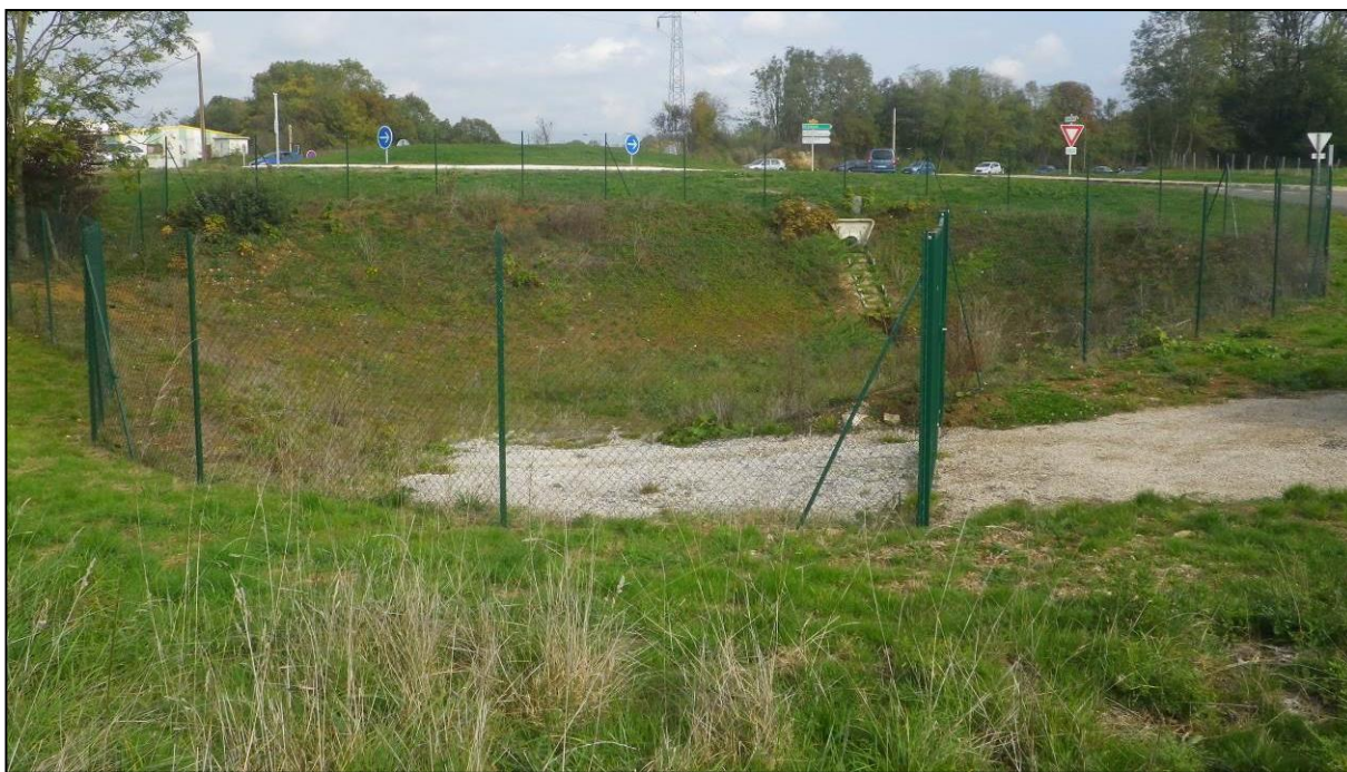
Bassin d'infiltration giratoire de la RD 673.
